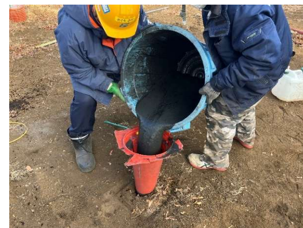
鑽孔深埋工法施工照片
