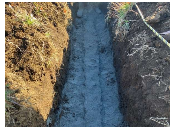
鑽孔深埋工法施工照片
